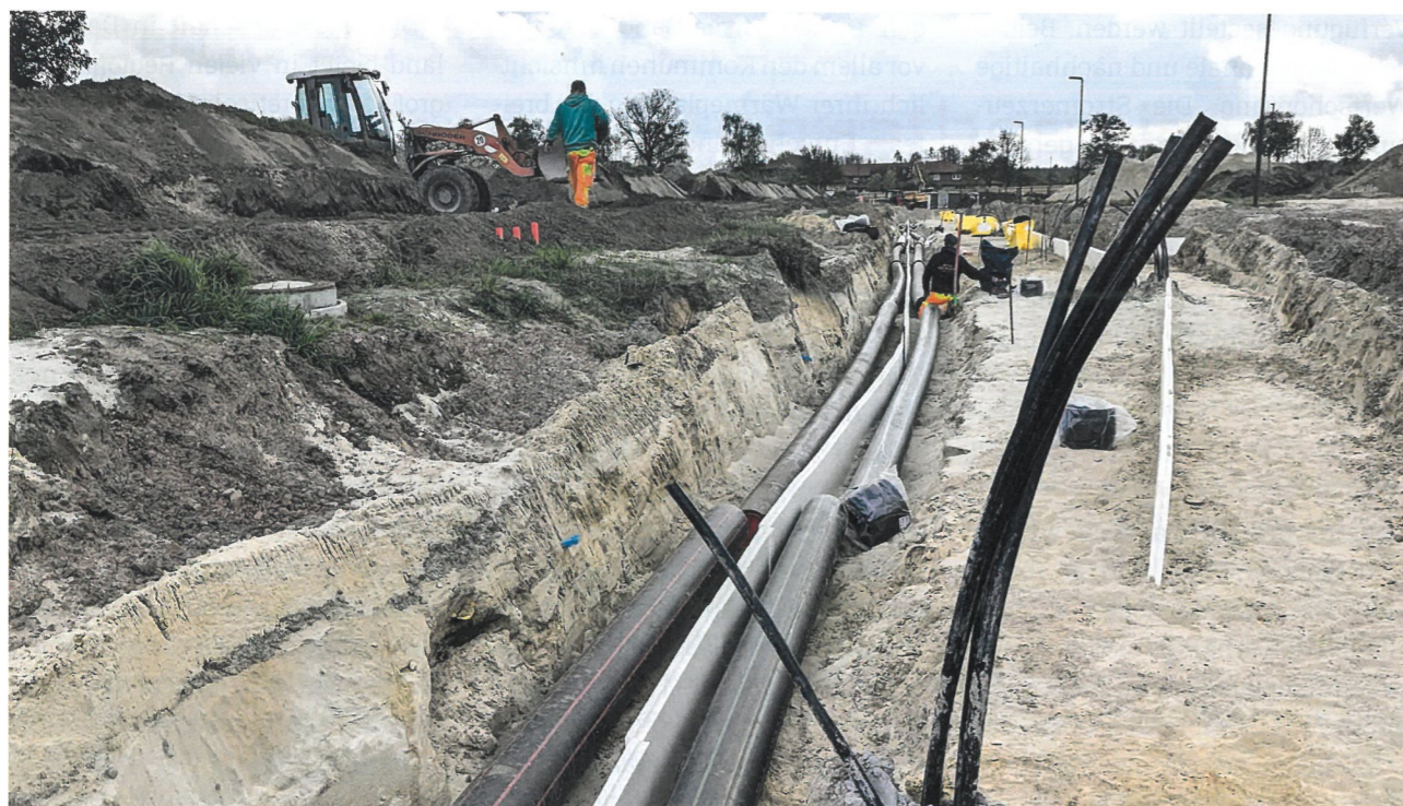
Ein kaltes Nahwärmenetz entsteht in Eschede: Nach Abschluss des ersten Bauabschnitts wurde nun mit dem zweiten von drei Bauabschnitten begonnen
