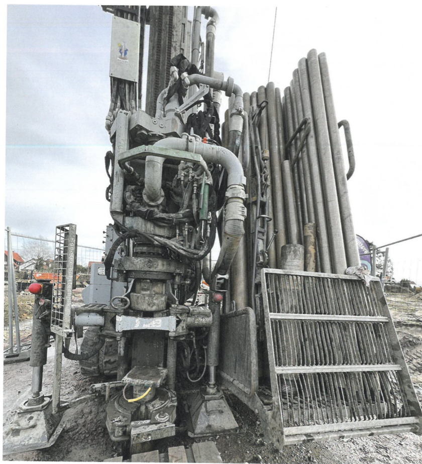
Bild 2. Zur Bestimmung der thermischen Ergiebigkeit des Untergrunds wurde eine Pilotbohrung durchgeführt, die auch den Nachweis über die Erfüllung der Fördervoraussetzungen erbrachte
