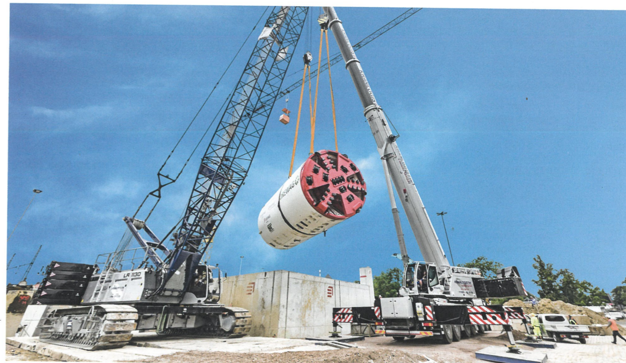
Eine AVND-Maschine wurde 2020 zur Querung der Elbe eingesetzt
