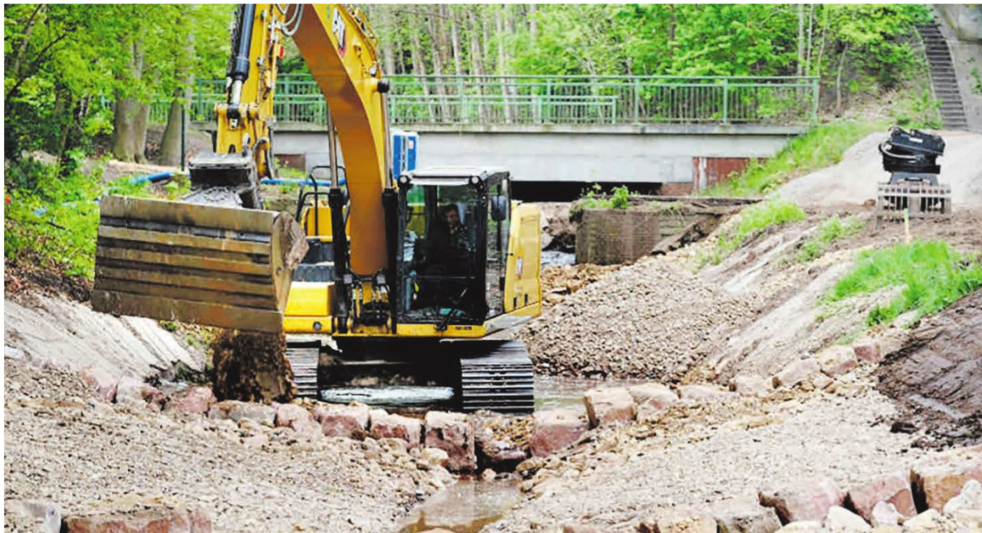
Die Bauphase der Fischtrappe an der Wehranlage Pultern soll bis etwa Mitte Juni andauern.
