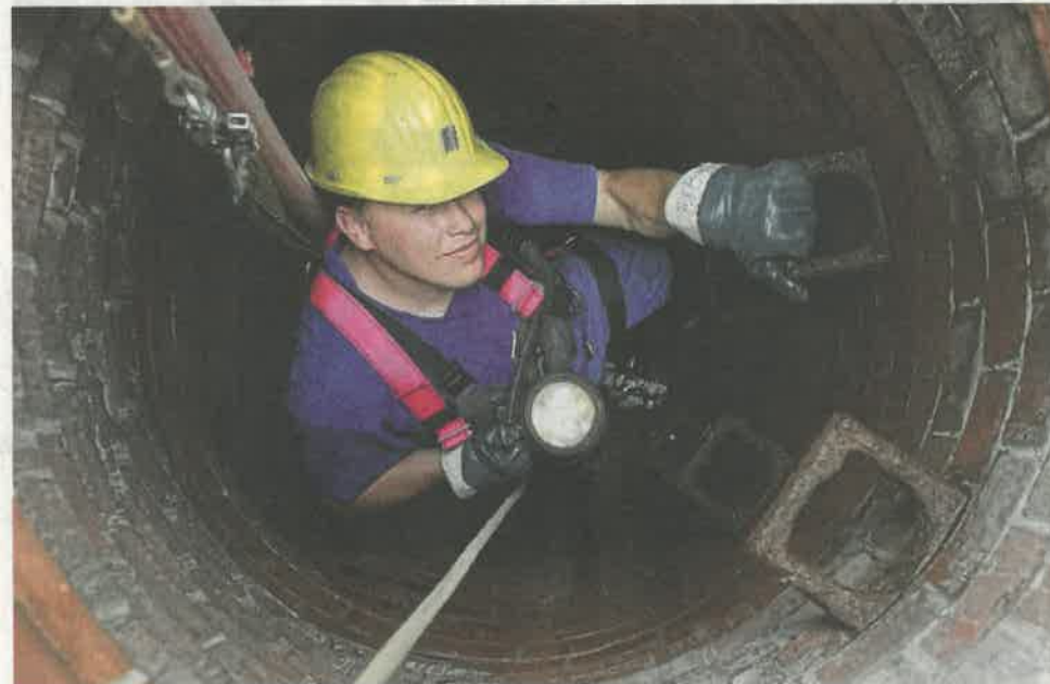
Im ersten Abschnitt werden derzeit Schmutzwasserkanäle in Stederdorf, Esterholz und Niendorf II saniert. Ab 2020 geht es in Teilen von Bad Bodenteich weiter. FOTO: DPA
