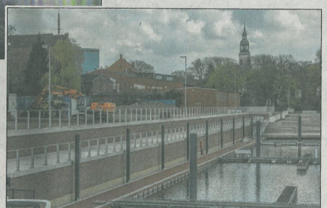
Erneuerte Kaimauern rahmen das Becken ein.
