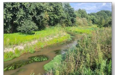
Der Meliorationshauptkanal in der Ortschaft Hoyerhagen im Landkreis Nienburg ist auf weiter Strecke durch einen sehr großen Fließquerschnitt bei gleichzeitig geringen Abflussverhältnissen geprägt. Zusammen mit einem geringen Fließgefälle führt dies zu einer Aufsedimentierung des Gewässers. Insgesamt weist das Gewässer ein eintöniges Erscheinungsbild von eher geringen ökologischen Wert auf.
