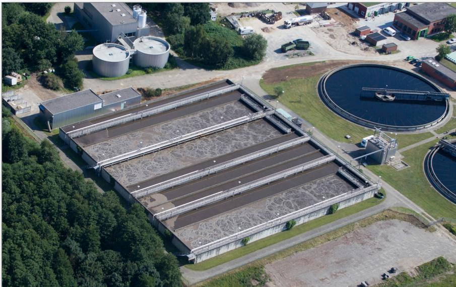
Die Kläranlage Lüneburg mit einer Ausbaugröße von 325.000 EW betreibt ein dreistraßiges Belebungsbecken zur biologischen Abwasserreinigung. Die zur Belüftung der Belebungsbecken erforderliche Druckluft wird durch Turboverdichter erzeugt. In den Becken stellten sich im Betrieb aufgrund von ungleichmäßiger Luftverteilung stark unterschiedliche Sauerstoffkonzentrationen ein.
