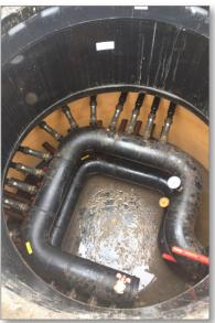
Im Neubau eines Verwaltungsgebäudes mit angeschlossenem Werkstatttrakt des Wasserverbandes Vorsfelde wird der gesamte Heiz- und Kühlbedarf geothermisch gedeckt.
